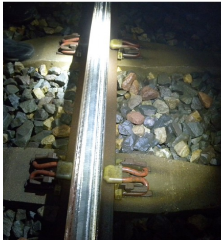
Rail après meulage
