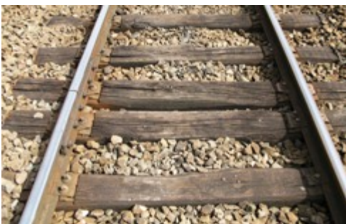
Rails courts sur traverses bois
